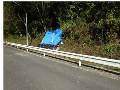
工事現場(着手前状況) 西側
