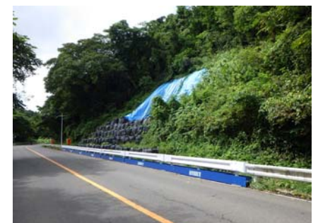
工事現場(着手前状況) 東側
